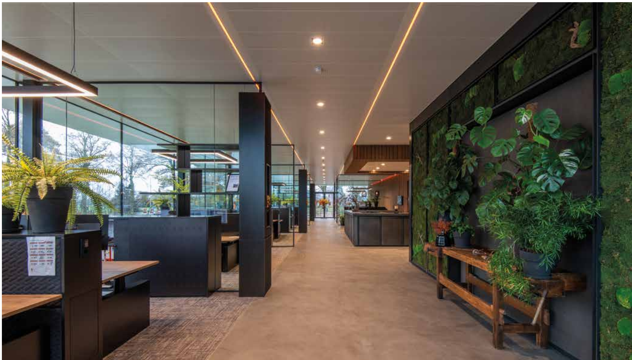
BOUWBEDRIJF VAN MIDDENDORP | WEKEROM | MAATWERK BANDRASTERPLAFOND MET LICHTLIJN EN VERDEKT SYSTEEM
