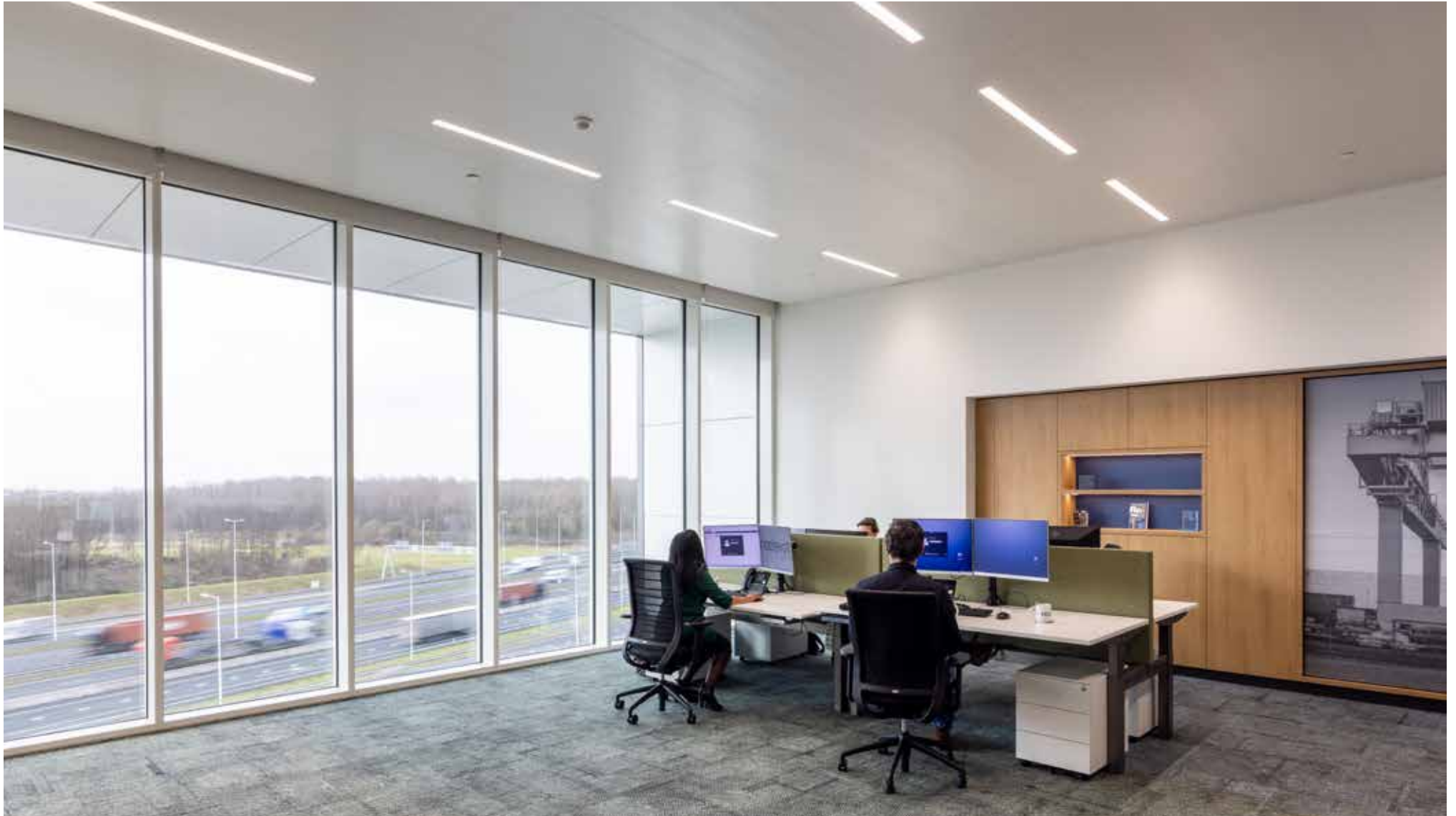
NEELE-VAT LOGISTICS | ROTTERDAM | VERDEKT SYSTEEM GESLOTEN KLIMAATPLAFOND
